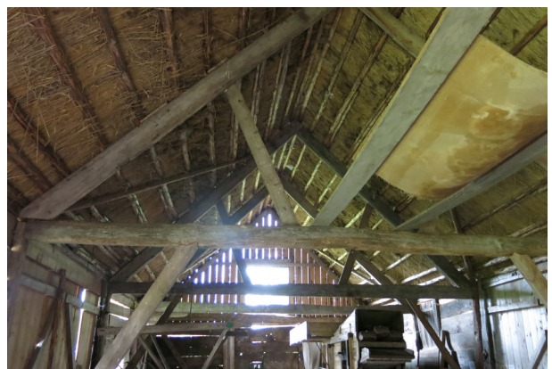
Taket sett inifrån.
