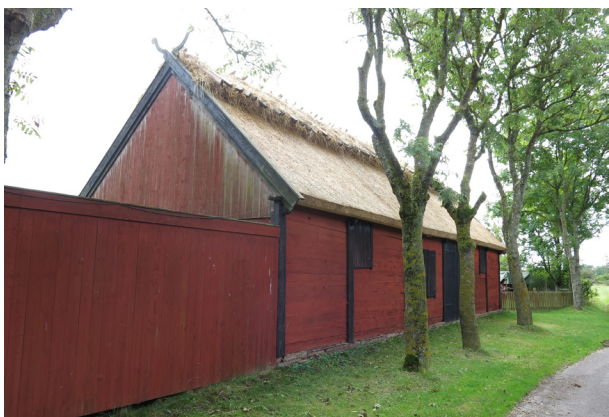
Maskinladans västra takfall efter åtgärderna.
