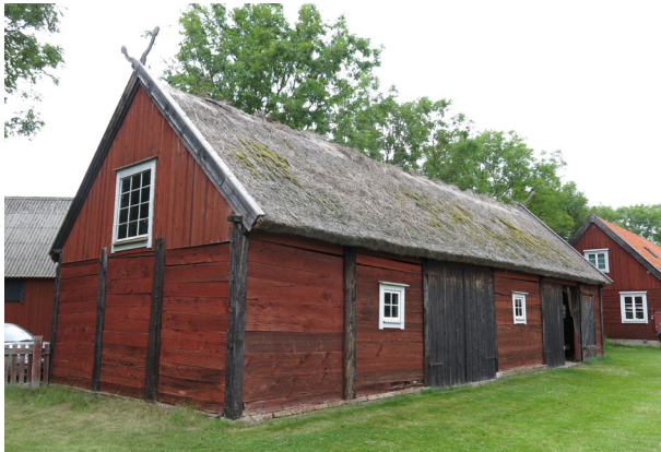
Maskinladans östra takfall före åtgärderna.
