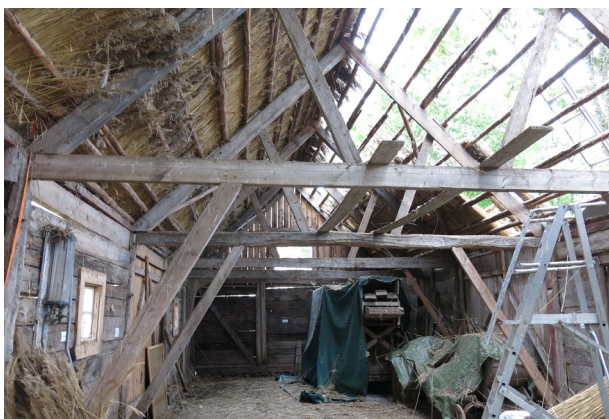
Östra takfallet är omlagt.
