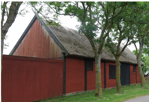
Maskinladans västra takfall före åtgärderna.
