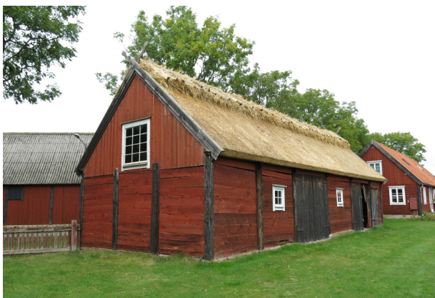
Maskinladans östra takfall efter åtgärderna.
